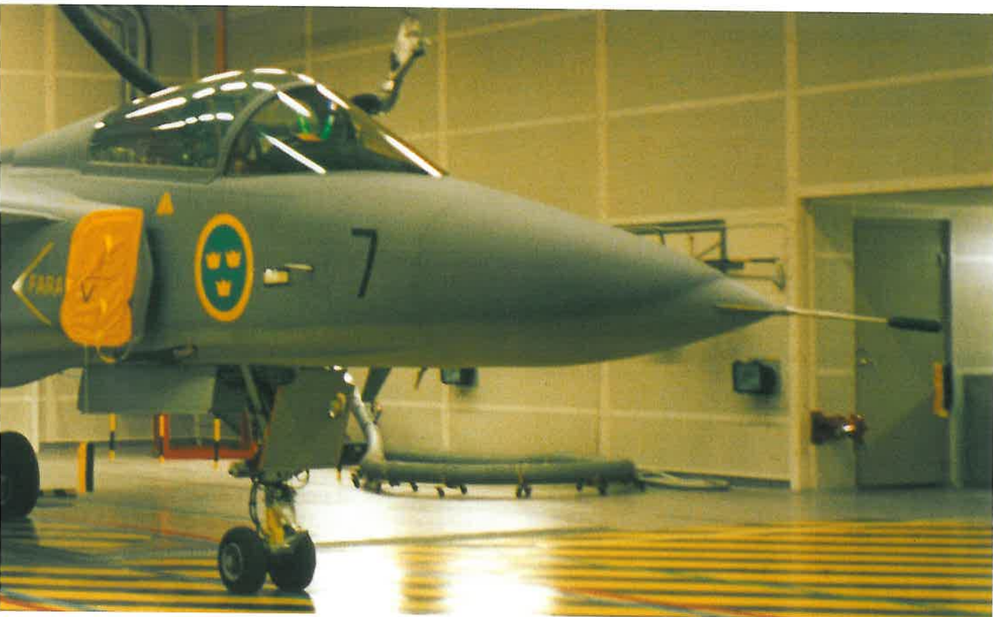
Bild: Interiör från nya motorprovhuset.
